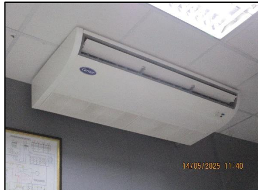
ภาพที่ 3.61 ห้องควบคุมที่ติดตั้งเครื่องปรับอากาศ
